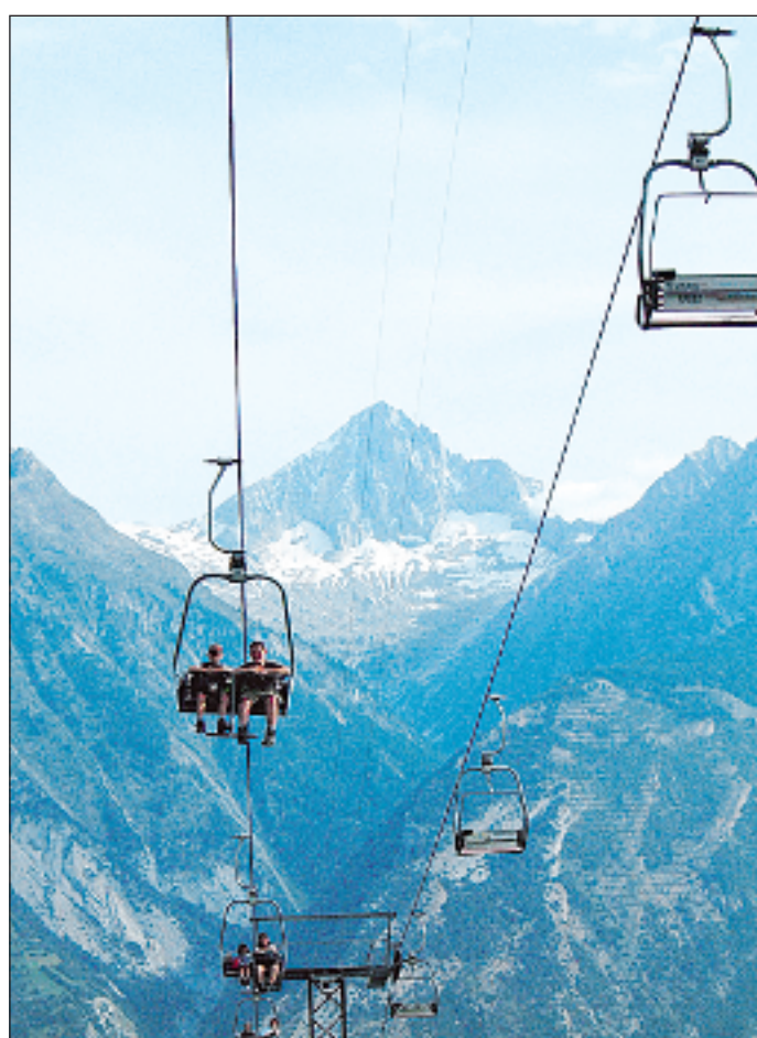
Rund 1 Million Franken bedarf die Sanierung des Sesselliftes «Brand 1»
