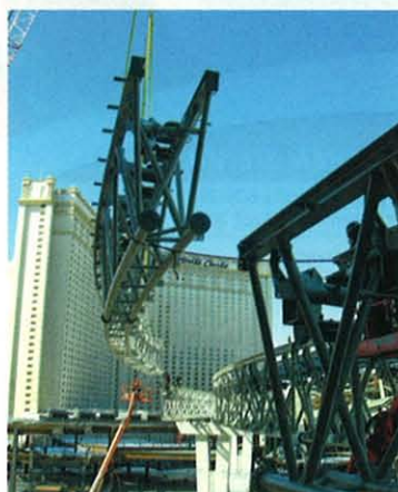
Einsetzen des letzten Tragwerksteiles der insgesamt 86 m langen Brücke
