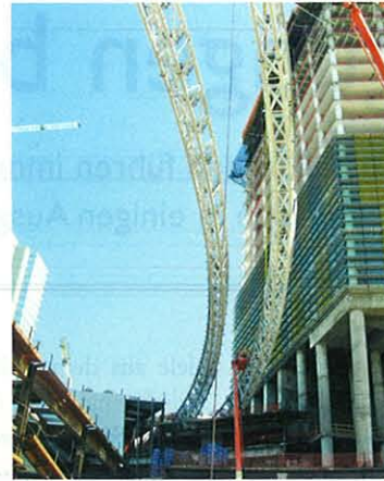
Die schlanken Brückentragwerke im langen Spannfeld von unten gesehen
