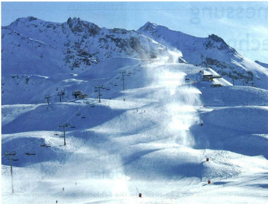
Die Steuerung der neuen Lanzenanlage in Val d'Isere erfolgt vollautomatisch.
