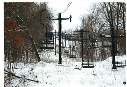
Förderseilentgleisung auf der Talfahrtsseite der Doppelsesselbahn, rechts im Bild die 3er-Sesselbahn der Parallelanlage
