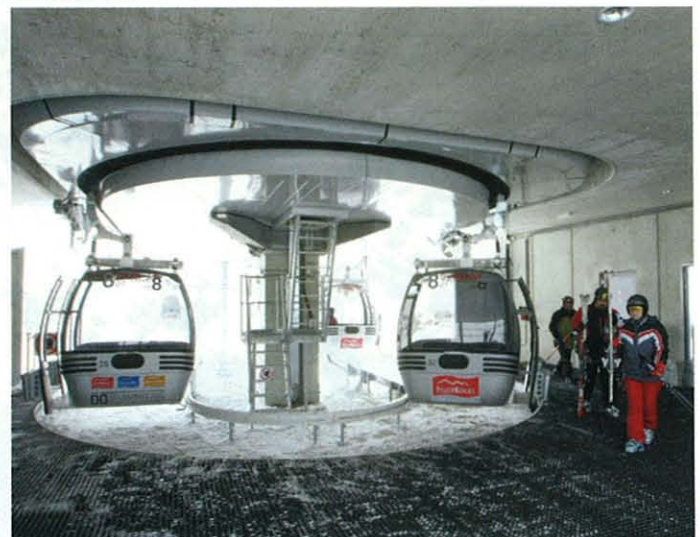
Umführungsbereich der Kabinen in der Bergstation der 8er-Kabinenbahn „Gsöll“
