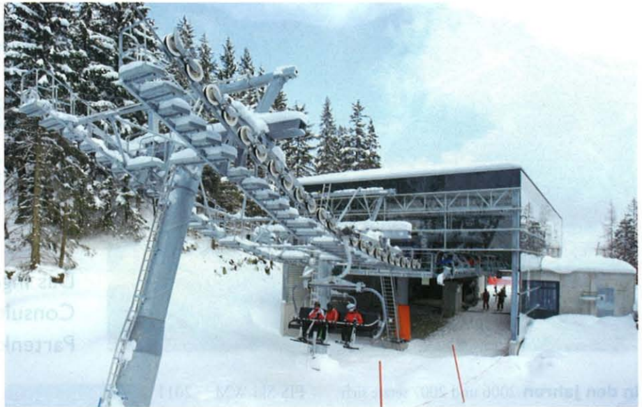
Ausfahrt aus der Talstation der 6er-Sesselbahn "Grubersunk"
