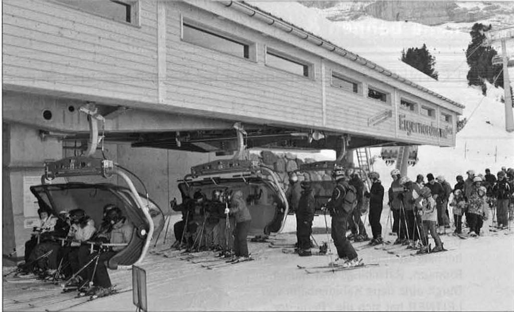
Erstmals in Grindelwald wurde an dieser Anlage der bequeme Längs-Zustieg für die Bahnbenutzer realisiert. Dabei werden die Fahrzeuge auf minimale 0,3 m/s Umlaufgeschwindigkeit reduziert.
