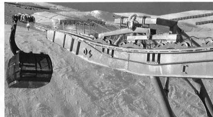
Bild 9: Ausfahrtstütze der Mittelstation mit Niederhaltebatterie für das Zugseil und Ablenkschuhen für die Tragseile unterhalb der Fahrbahn für die Laufwerke
