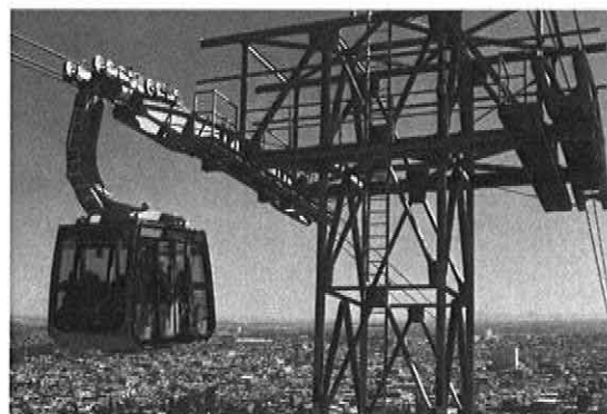
In Mexiko, im Bundesstaat Durango, baute BMF eine Pendelbahn.
