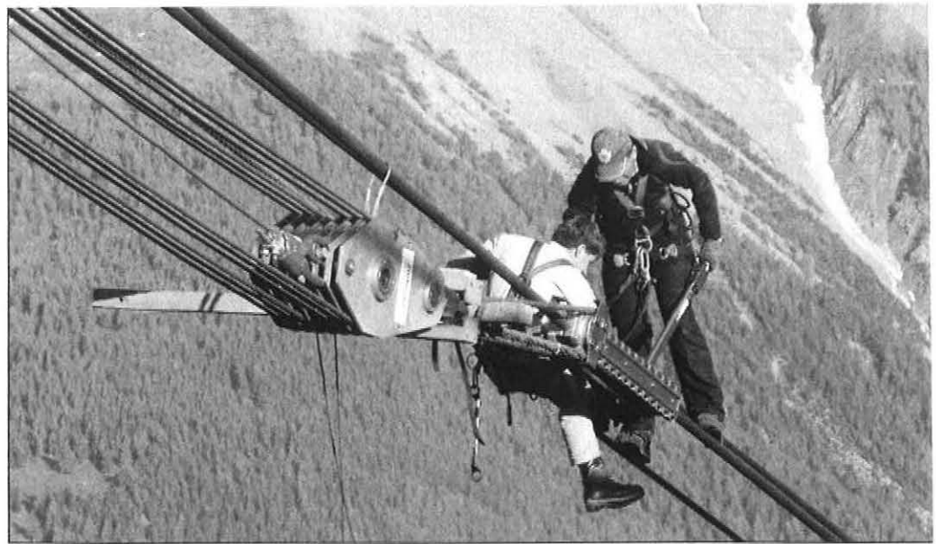
Einfache Handhabung der Klemmplatten aus Aluminium: Seilschieben auf der Riederalp (CH) ...
