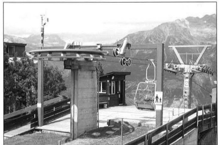
Aus „alt“ mach (fast) „neu“ beim fixen 2er-Sessellift Unterbäch - Brandalp: Der von der BMF AG durchgeführte Umbau umfasste die Stützenköpfe, die Rollenbatterien, die fixen Klemmen und die Umlenkscheibe am Berg - dazu wurden die Fahrbetriebsmittel erneuert.
