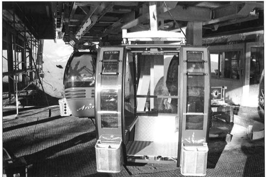
In Arosa wurde ein 3er-Sessellift in eine kuppelbare 4er-Kabinenbahn umgebaut.
