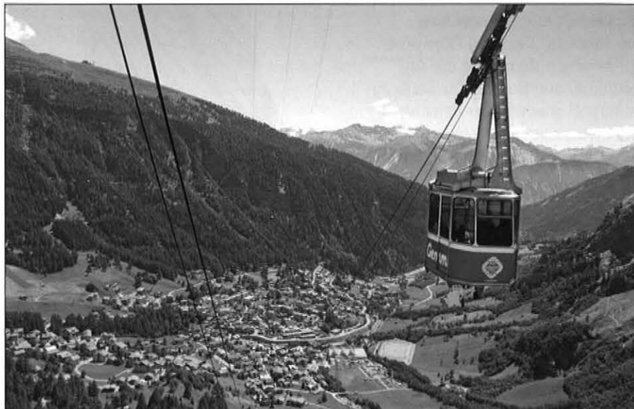
Der österreichische Stahlseilspezialist TEUFELBERGER hat kürzlich vom Schweizer Seilbahn-Bauer BARTHOLET den Auftrag für die Beseilung der neuen Pendelbahn Leukerbad erhalten.
