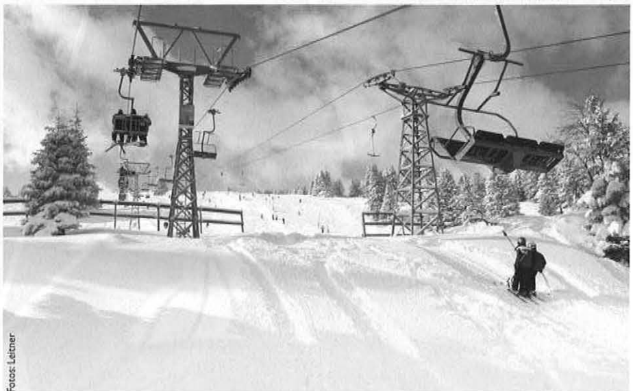
Die zu ersetzenden Anlagen in Savognin
