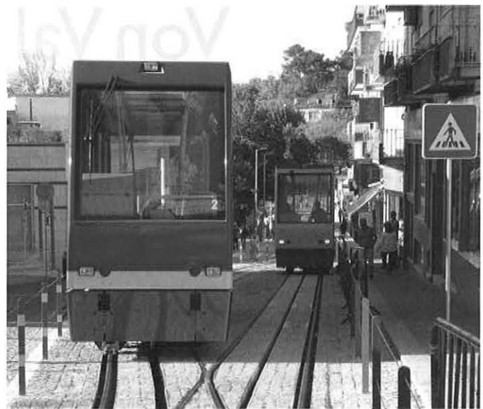
Bereich der Ausweiche, niveaugleich mit der Straße
