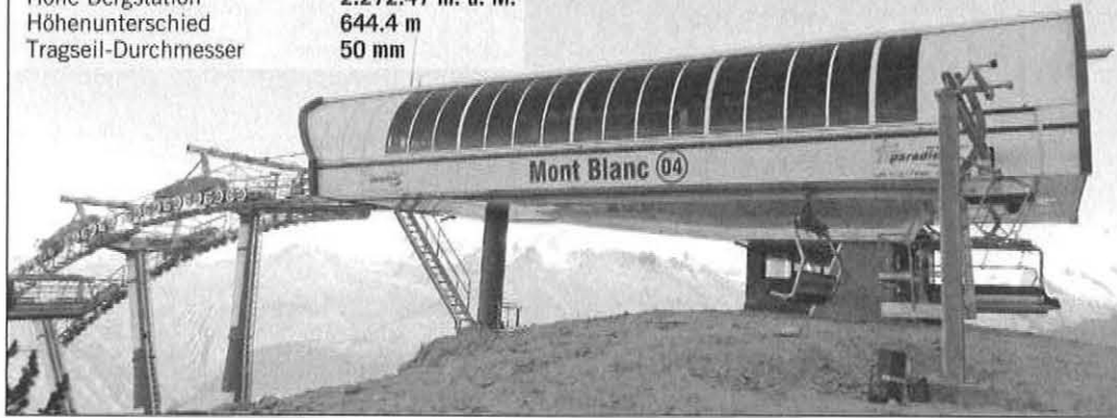
Mit dem 6er-KSB „Mont Blanc“ realisiert die BMF AG bereits die zweite kuppelbare Anlage in Les Arcs, was mit Sicherheit die Zufriedenheit mit der bestehenden BMF-Anlage widerspiegelt.
