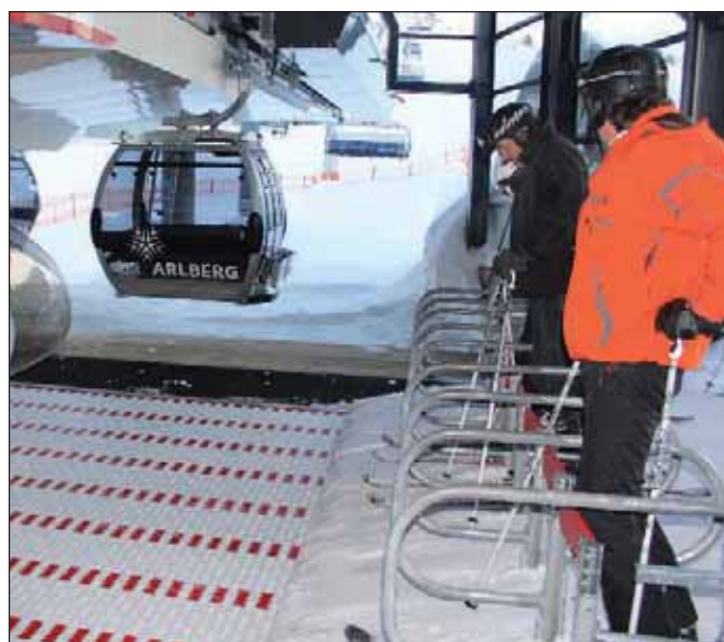
Damit die Skifahrer zum Sessel-Einstieg zu kommen, müssen sie mittels Förderband erst die Seil-Linie der Kabinen-Strecke queren: Um hier auf jeden Fall eine problemlose Passage zu ermöglichen, mußte das Förderband speziell „tiefer gelegt“ werden.
