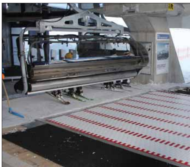
Damit die Skifahrer zum Sessel-Einstieg zu kommen, müssen sie mittels Förderband erst die Seil-Linie der Kabinen-Strecke queren: Um hier auf jeden Fall eine problemlose Passage zu ermöglichen, mußte das Förderband speziell „tiefer gelegt“ werden.
