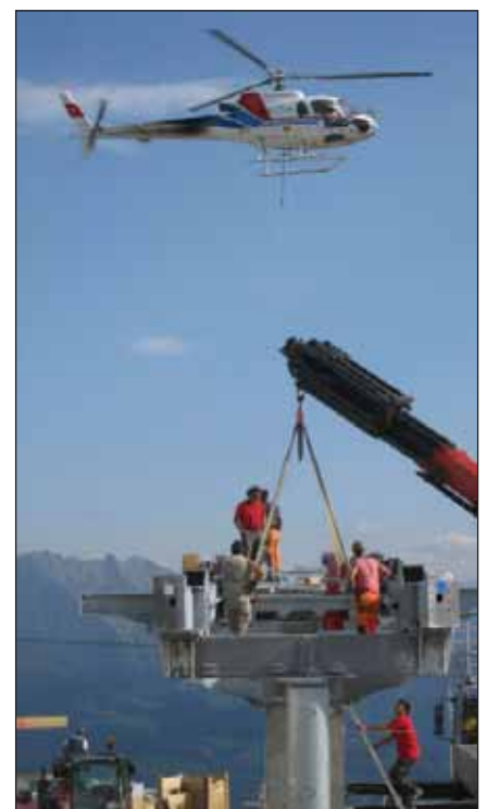
Einsatz aus der Luft und vom Boden: Stützenmontage in der „Weisse Arena“.
