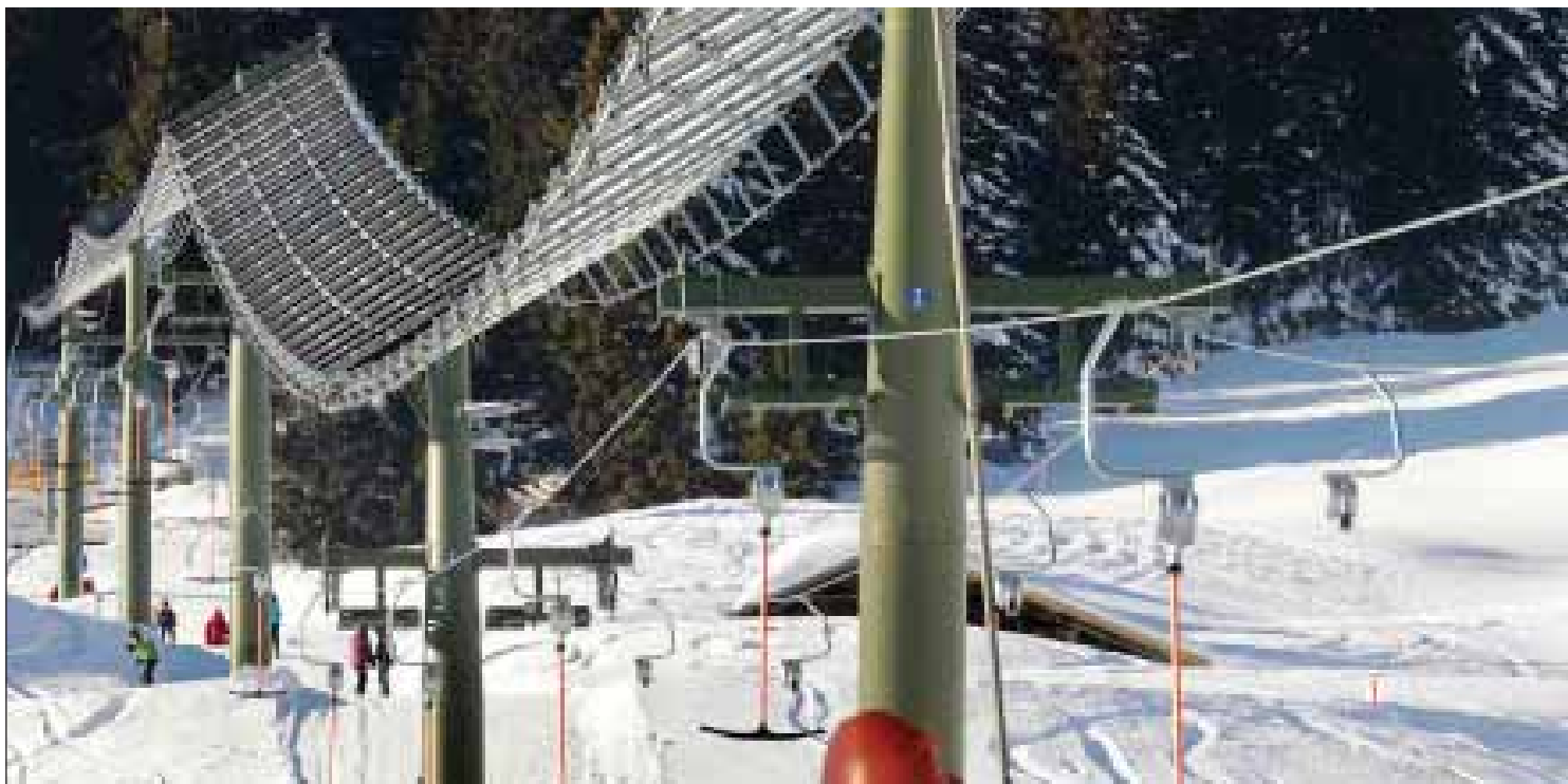
Bei einer installierten Leistung von 62 Kilowatt produziere der Skilift rund 90 000 Kilowattstunden im Jahr, rechnet Christian Hassler von Hassler Energia Alternativa in Zillis vor. Die Firma, die 2000 den Schweizer Solarpreis erhielt, hat die Photovoltaikanlage installiert. Fotos: Si / Hans-Jörg Egger
