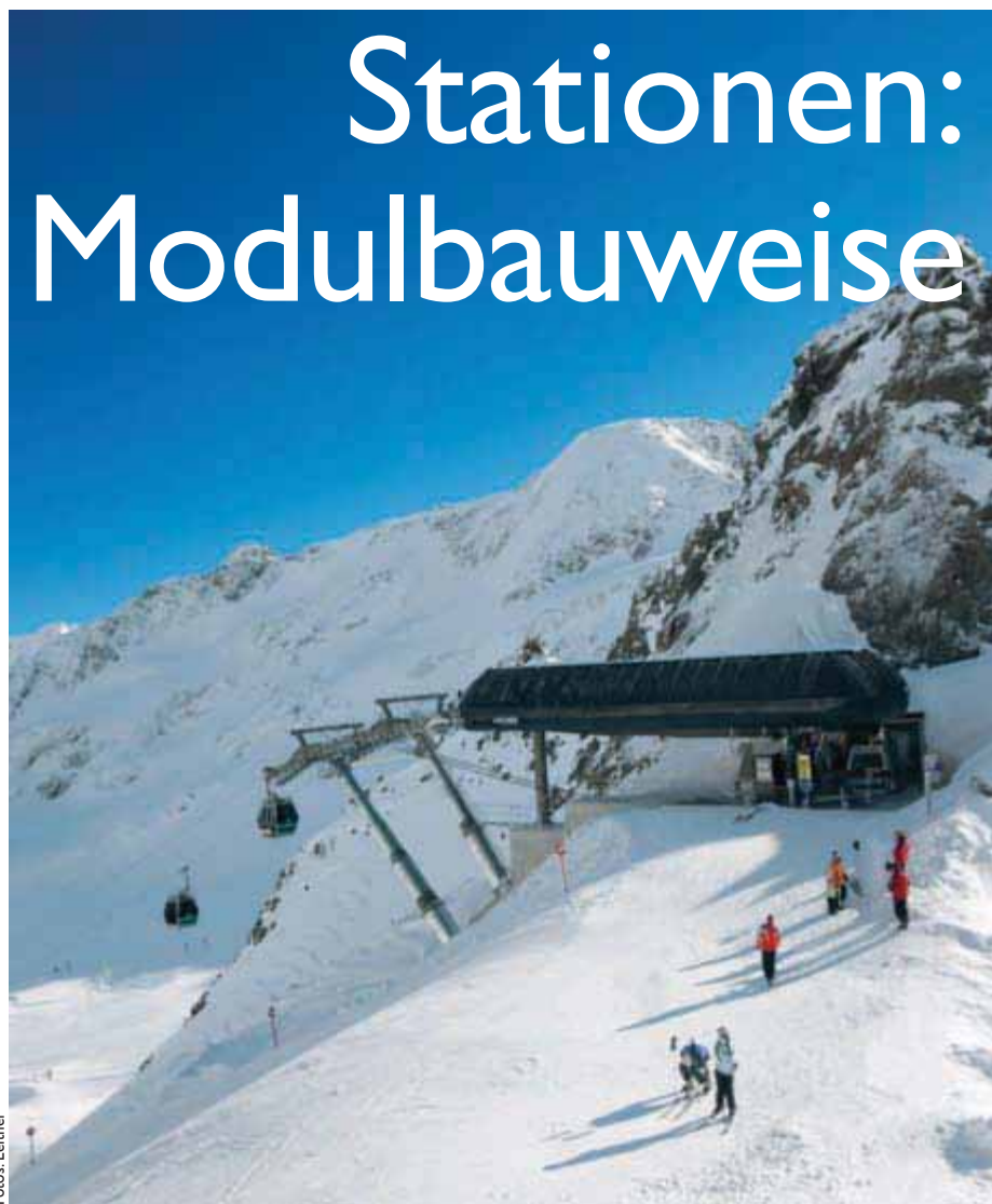
Die Standard-Station von Leitner, im Bild als Bergstation
