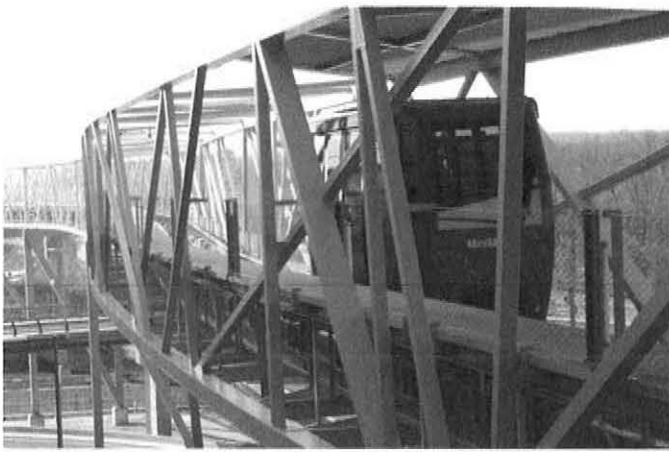
Die Metro fährt in einem Rahmentragwerk, dem Skylink.
