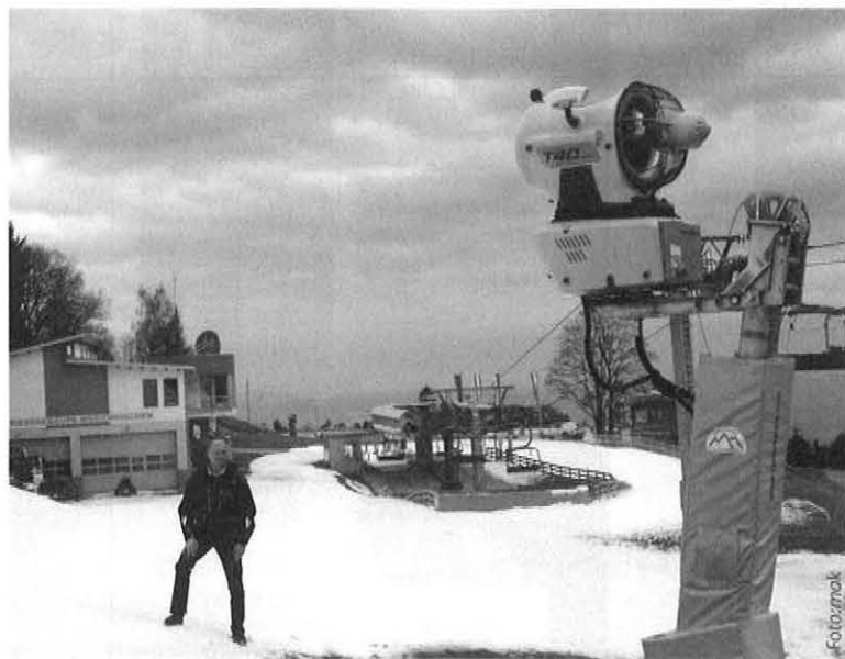
Eine von 63 Turmmaschinen der Marke TechnoAlpin in Mönichkirchen-Mariensee. Bei der Planung konnte sich das Ingenieurbüro AEP auszeichnen.
