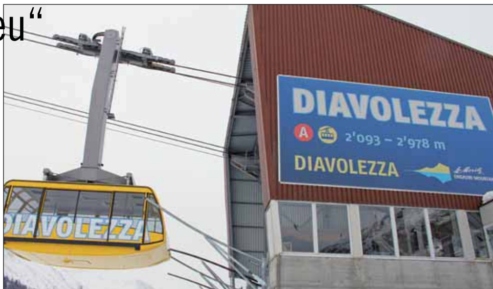
Aus den „goldenen Jahren“ des Schweizer Seilbahn-Baus: Die Diavolezza wurde 1956 errichtet.
