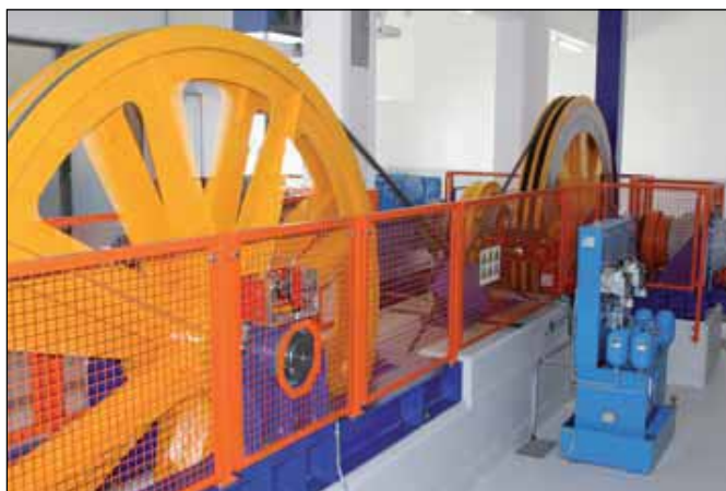
Die Umlenkscheiben wurden auf Risse geprüft, neu gefüttert und gelagert. Für den notwendigen Grip läuft das Antriebsseil in einer 8er-Schleife
