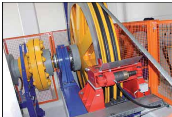
Die Umlenkscheiben wurden auf Risse geprüft, neu gefüttert und gelagert. Für den notwendigen Grip läuft das Antriebsseil in einer 8er-Schleife
