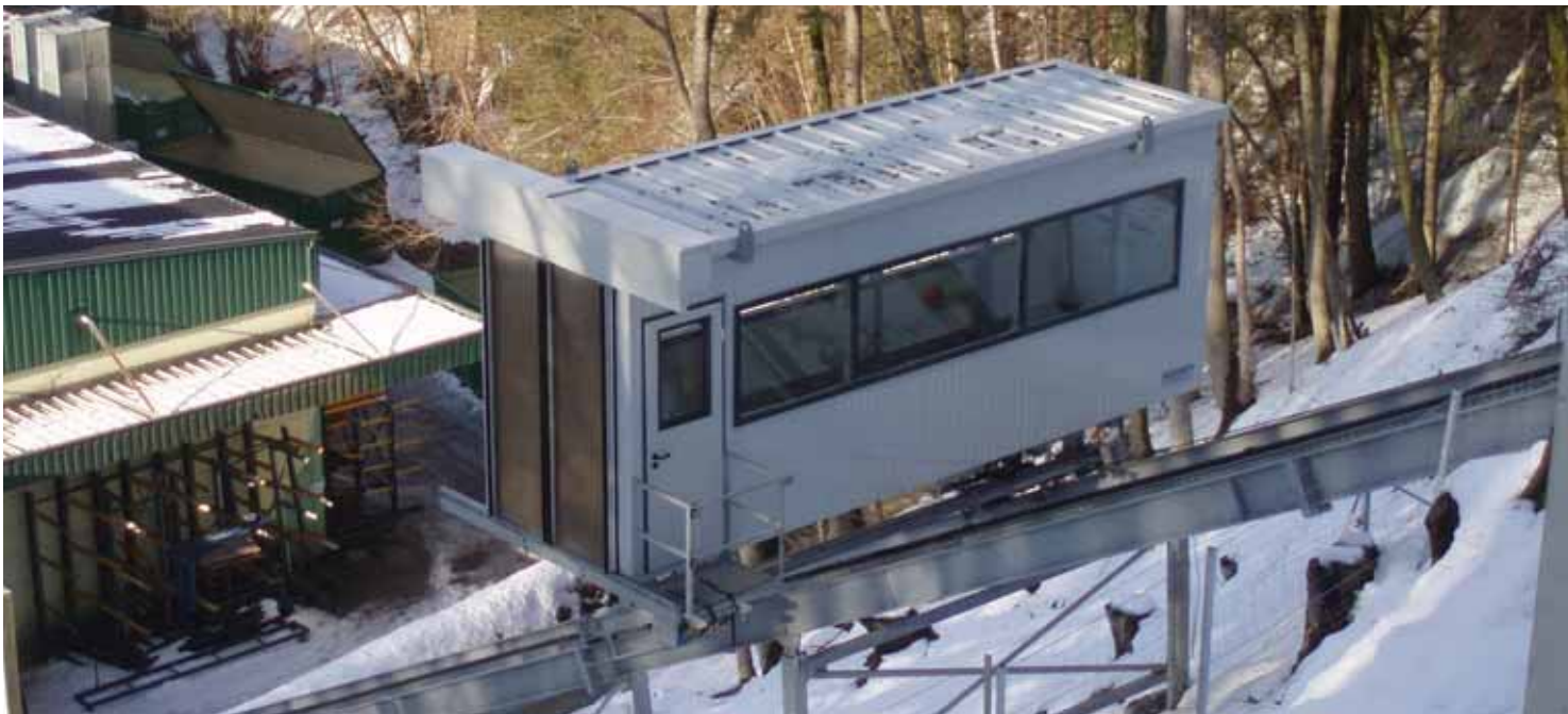
Das SCHLOTTERER-Stammhaus auf dem Talboden wird nunmehr mit einem 50 Meter langen Schrägaufzug mit der neuen Produktionshalle verbunden.
