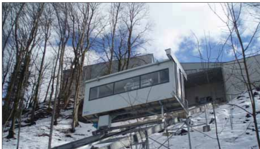
Die technische Lösung für den Schrägaufzug kam aus Frastanz in Vorarlberg.
