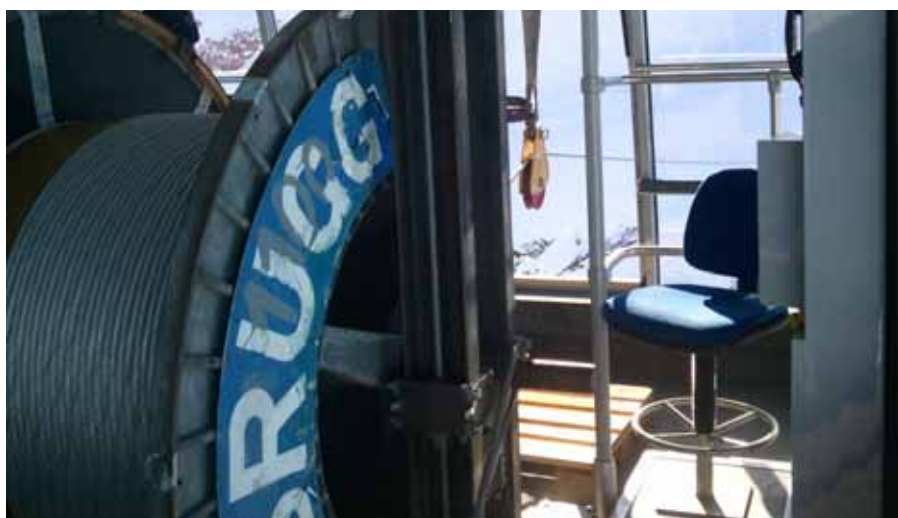
Das neue Telecomseil wurde durch das frontseitige Evakuierungsfenster herausgeführt.
