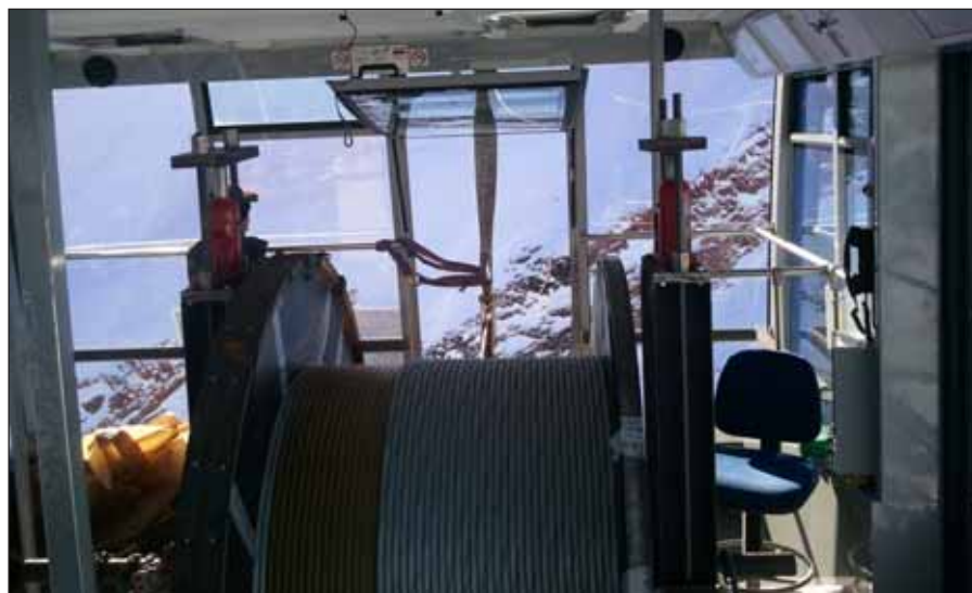
In der Kabine wurde für die Seil-Bobine eine speziell angefertigte Abspul-Vorrichtung eingerichtet.
