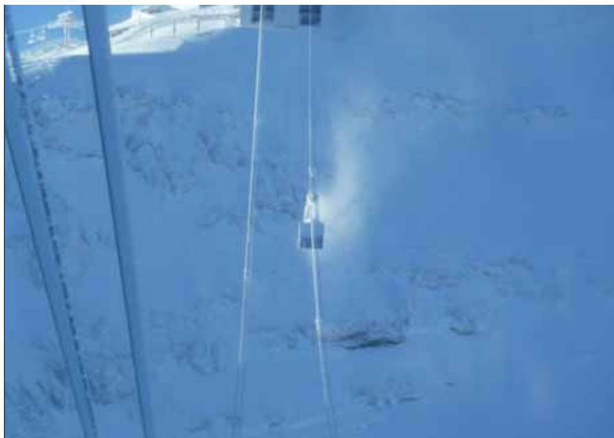
Sorgfältig wurde das Seil bei langsamer Talfahrt unter Spannung aus der Kabine herausgelassen.
