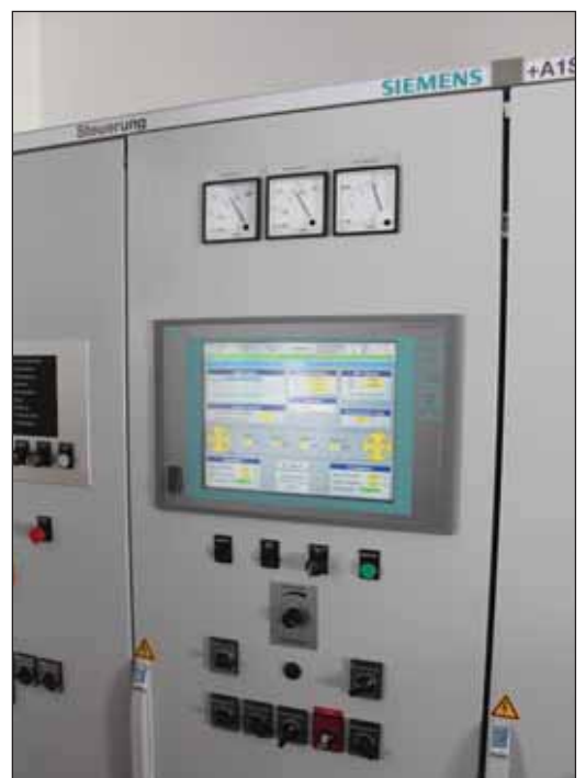
Bei der Steuerung setzten die Saalbacher Bergbahnen auf eine Simatic-S7-319F Automatisierungseinheit
