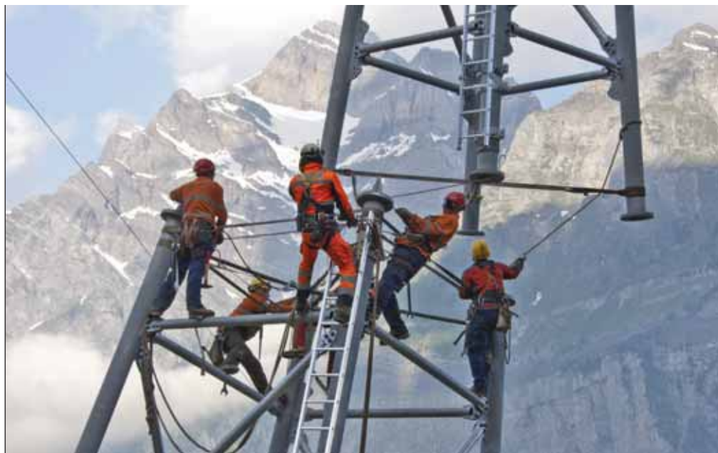
„Schlüsselfertige“ Montage der Kompakt-Seilbahn durch das INAUEN-SCHÄTTI-Team Foto: Urs Heer
