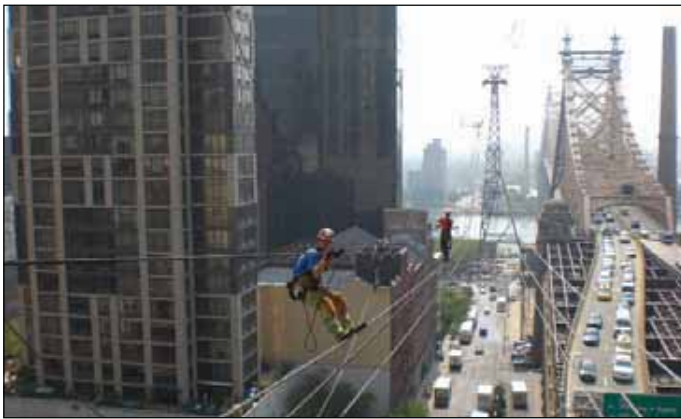
Einsatz in Manhattan: Für POMA absolvierte das ZURBRÜGG-Team den Seilzug bei der Erneuerung der Luftseilbahn zum Roosevelt Island
