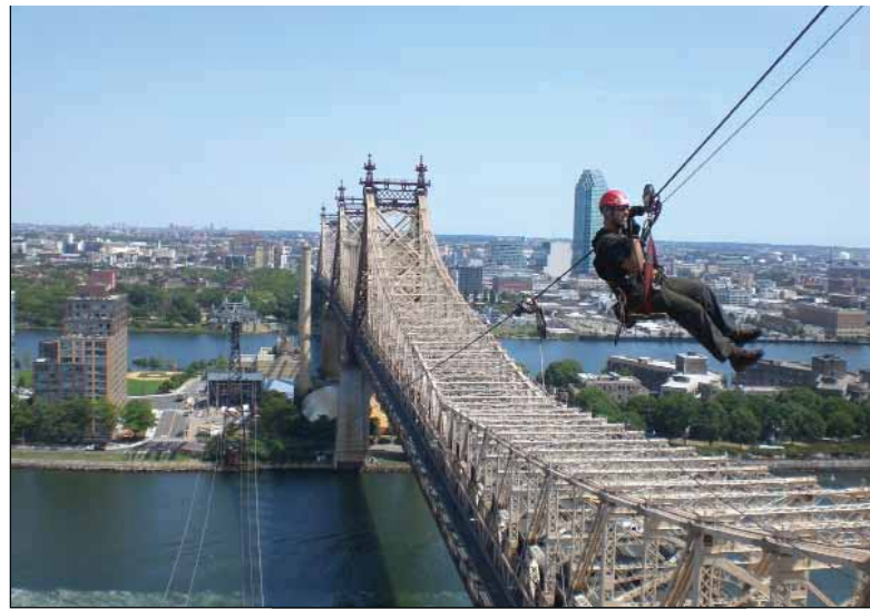
Einsatz in Manhattan: Für POMA absolvierte das ZURBRÜGG-Team den Seilzug bei der Erneuerung der Luftseilbahn zum Roosevelt Island
