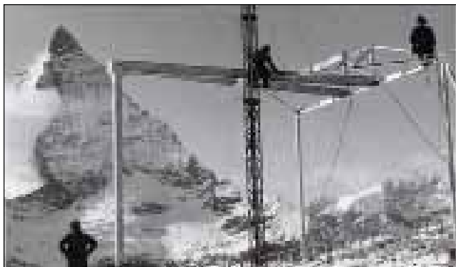
In den 60er-Jahren eine ingenieurstechnische Sensation: Die Montage der ersten Gletscher-Schleplifte in Zermatt auf 3.500 m Seehöhe
