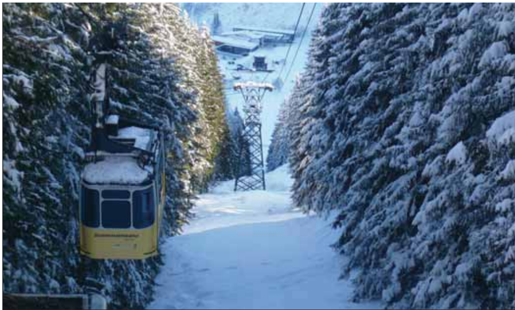
Der Umbau der Sonnenalmbahn in Zell am See, eine Ein-Tragseil-Luftseilbahn mit zwei Großraumkabinen im Pendelbetrieb, wurde Ende 2011 abgeschlossen. Fotos: LEITNER
