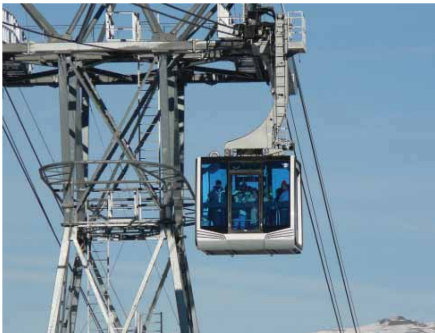
Sicherheit und Laufruhe bei Seilbahnen dank Redmont7 von REDAELLI.
