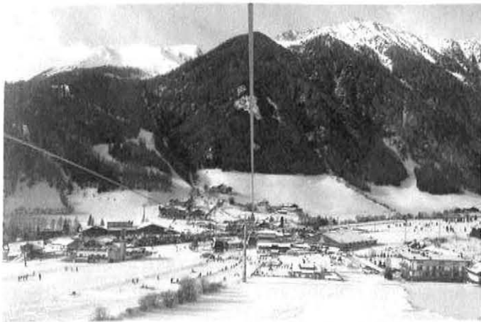
Die Talstation der Gaisjochbahn wurde auf 1 633 m Seehöhe gebaut.
