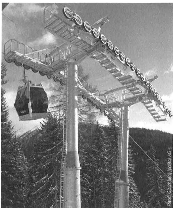
Mit der 8er Kabinenbahn „Gaisjoch“ wird die Verbindung Gitschberg und Jochtal Realität.
