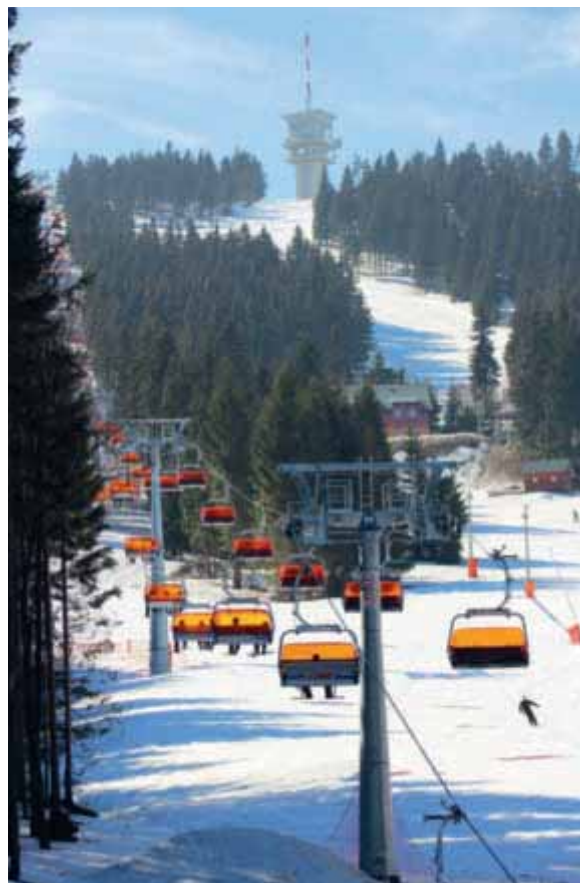
Blick von der Talstation auf die Trasse der Sesselbahn mit der ausgebauten Piste, im Hintergrund der Sendeturm am Klínovec
