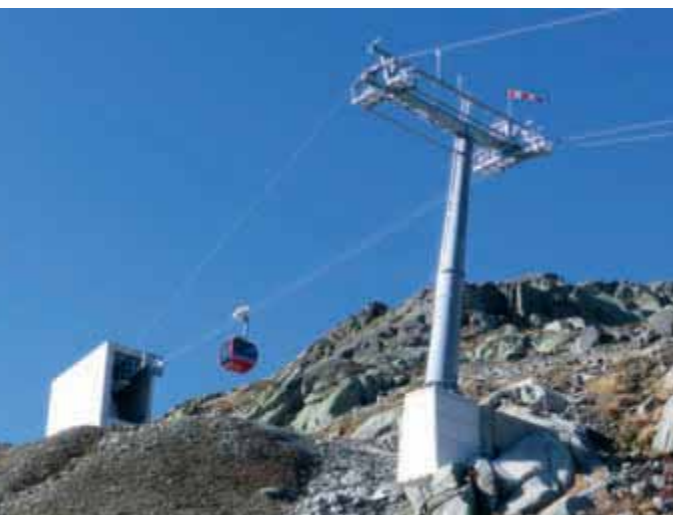
Bergstation der Pendelbahn Grimselnollen-Hausenegg mit vorgelagerter Stütze
